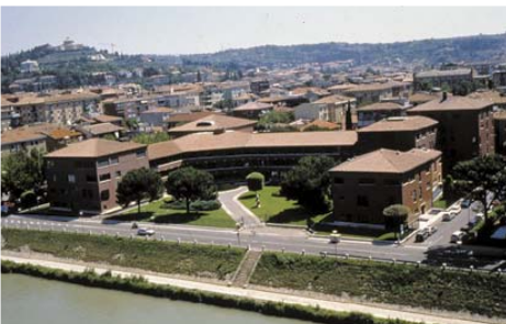
▼ Vista aerea della Sede della Direzione Generale della Società Cattolica di Assicurazioni di Verona
